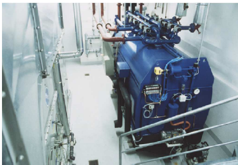
รูปที่ 2 เครื่องทำน้ำเย็นชนิดดูดซับ (adsorption chiller) [3]
